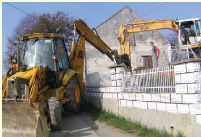
Strojevi ruše ogradu kako bi se olakšao izlazak na novouređenu prometnicu.
