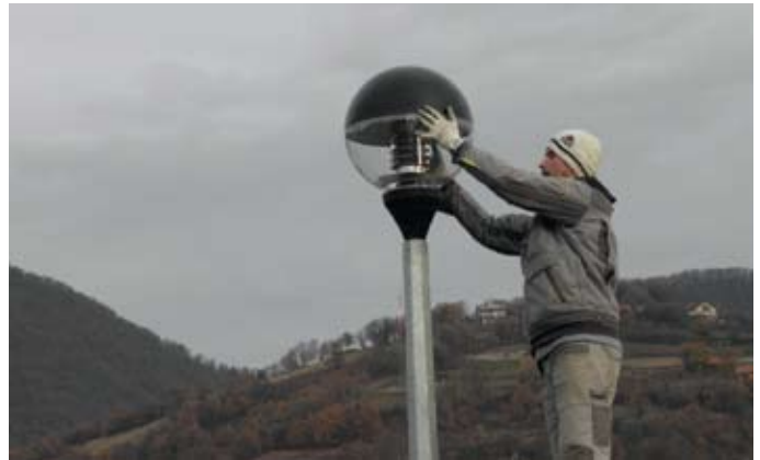
Rekonstrukcija javne rasvjete u Radoboju.
