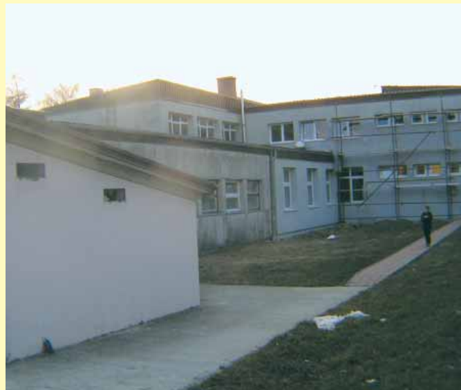
Na ovom dijelu sadašnje školske zgrade u Radoboju trebala bi se izvršiti dogradnja.
