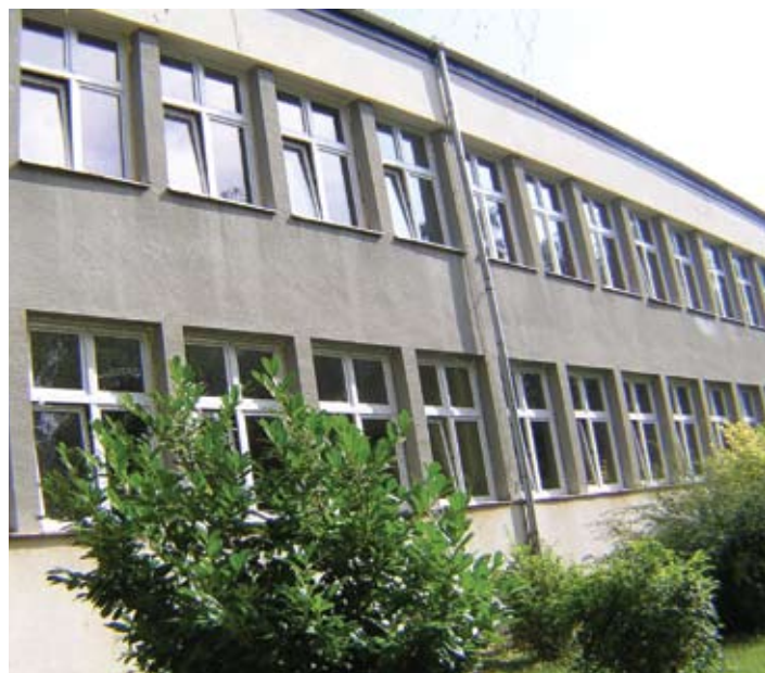
Zgrada OŠ Side Košutić u Radoboju dobit će nove prostore, što će omogućiti jednosmjensku nastavu.
