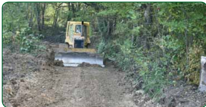
Izrada šumske ceste podno Strahinjčice
