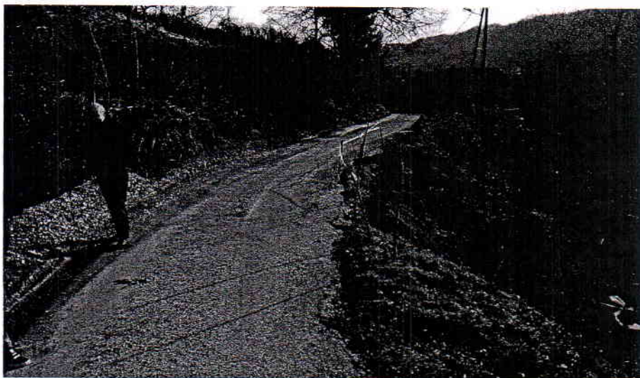
Slika 8. Pogled na klizište Obadići u smjeru istoka. Jasno je vidljivo čelo klizišta
