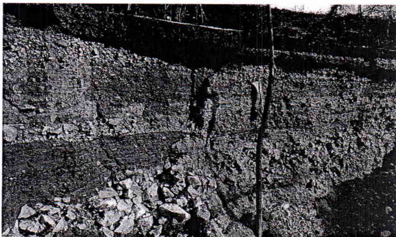
Slika 9. Pogled na slojeve nasipa ispod ceste
